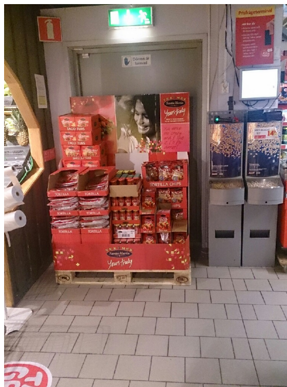
Ett tillsynsbesök 2013 - blockerad utrymningsväg
