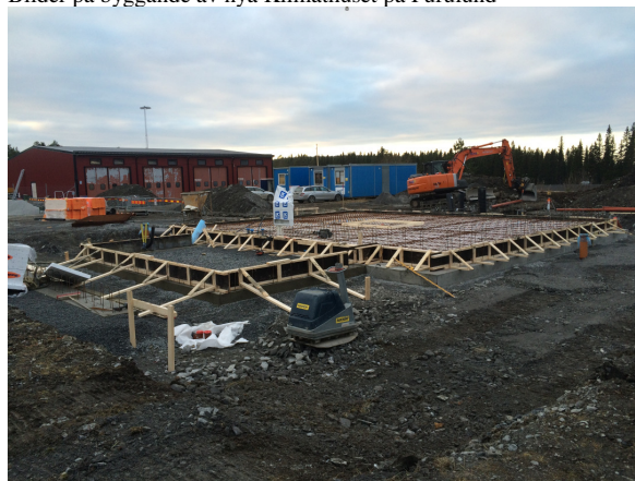
Bilder på byggande av nya Klimathuset på Furulund
